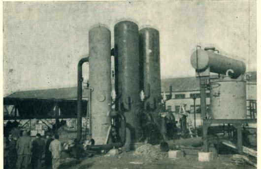
Tanques de decantación y separadores de entrada, primer proceso que cumple el gas al ingresar a la planta que será habilitada en Cañadón Seco, con capacidad para bombear un millón de metros cúbicos de gas natural por día; volumen será absorbido por el consumo de la población y la industria de Comodoro Rivadavia.
