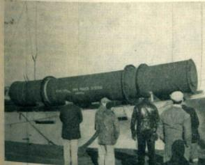
Maquinaria para Industrias Pesqueras Atlántico Sur que se instalan en Puerto Deseado. Vemos sobre cubierta, tal como lo condujo el b/y "Aca", de bandera danesa, un cilindro secador de 15 metros de largo, 2,75 mts. de ancho y 22 toneladas de peso. En la siguiente fotografía, otra maquinaria durante su descenso.
