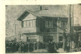
Edificio "anexo" construido en San Martín y Roca. En los altos, casa de gerentes.
