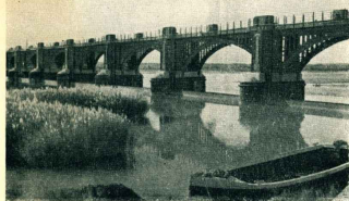
Vista parcial del dique construido en Contarlamirante Colorado, sobre el río Neuquén, que provee riego para 35.000 hectáreas.
