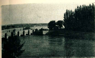
Bocaoma y canal principal derivado del río Neuquén, que se extiende hasta Chichinales, distante 135 kilómetros. En su recorrido este canal alimenta 15 canales secundarios.
