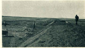
Construcción de la Ruta Nº 36, de Río Grande a Spiritus Santo. Terraplenes en progresión a la altura del Km. 45,4.
