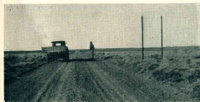
Conservación del kilómetro 112, correspondiente a la Ruta Nº 3, San Julián a Río Gallegos.
