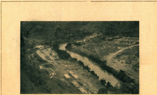
El Rio Chubut en el lugar de emplazamiento del dique Florentino Ameghino, con una vista general de las instalaciones levantadas para los trabajos de construcción.
