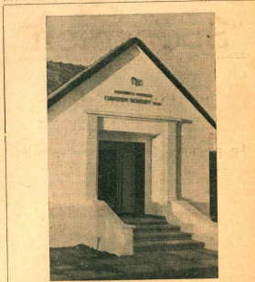
Entrada principal. El edificio está en el centro del pueblo, en un paraje alto. Río Grande, con un suelo compuesto de arcilla y piedra, carece de árboles. Para tornarse con arbolado la construcción, hubo que abrir dos zanjas de 50 m. y una de 25 m. de largo, por 1 m. de ancho y 1,50 de profundidad y rellenarlas con tierra negra, trizada de larga distancia en camiones. Allí, en pleno invierno, se trasplantaron 100 árboles de la zona boscosa (árbol) y pinos de varias especies, que gracias a los solícitos cuidados están prosperando.
