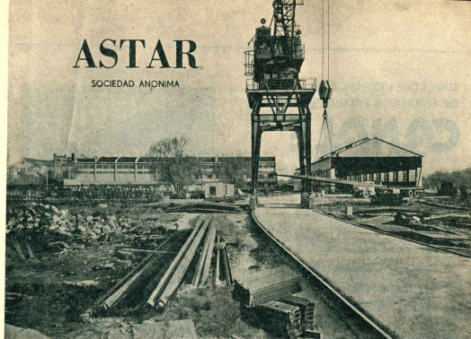
Vista desde ASTARSA de los edificios de Nyrast (a la izquierda con techo negro) y S. A. ASTAR; de frente una grúa de 20 toneladas transporta los elementos prefabricados de ASTAR hacia los varaderos del Astillero Astarsa.
